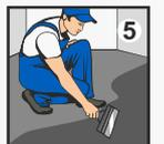
5 Раствор разлейте на поверхности по маякам, установленным параллельно друг другу на расстоянии на 15-20% меньшем длины правила, и распределите широким правилом. При слое меньше 5 мм установка маяков не требуется. Выравнивание поверхности производите за один прием, без перерывов.
